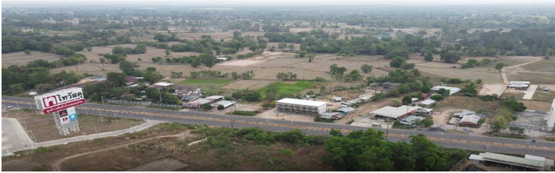
สภาพพื้นที่บริเวณจุดตัดทางหลวงหมายเลข 221
