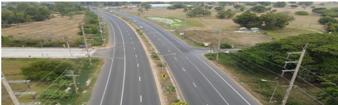
สภาพพื้นที่จุดเริ่มต้นโครงการ (ทางหลวงหมายเลข 294 บริเวณประมาณ กม.6+500)
